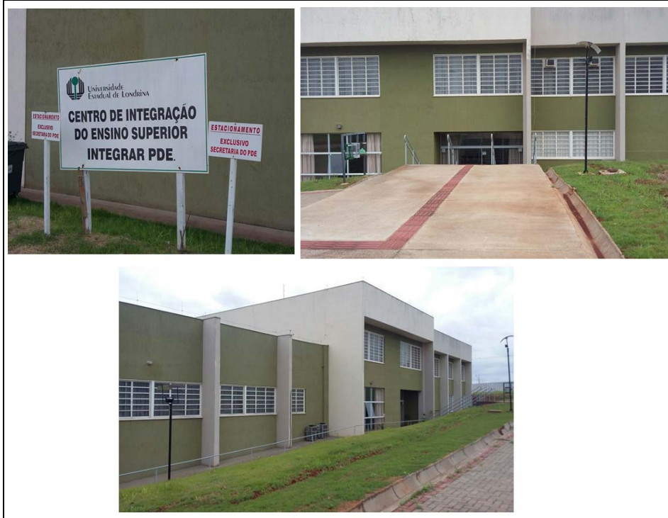
Figura 7 – Fachada do prédio do PDE na Universidade Estadual de Londrina.
