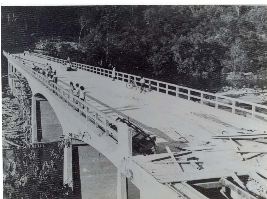
Figura 19 – Construção da ponte sobre o rio Tibagi
