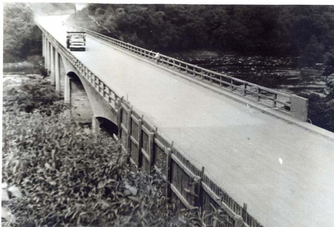
Figura 5 – Ponte sobre o rio Tibagi
