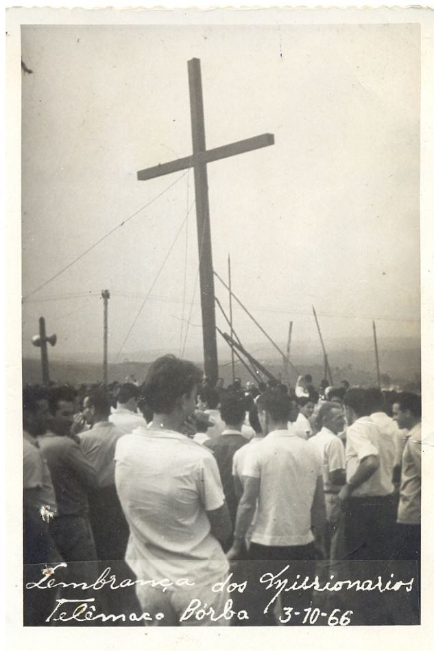
Figura 22 – Instalação de um dos cruzeiros de Telêmaco Borba, em 3 de outubro de 1966, durante a visita dos padres missionários
