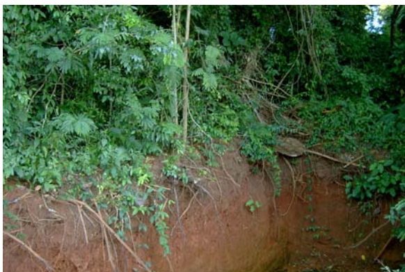
Foto 25 – Perfil do solo no local de instalação dos anéis. Fonte: Parizoto, D.G.V. (2007).
