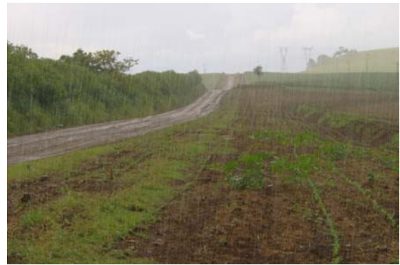
Foto 20 – Escorrimento no leito da estrada após 15min. de chuva. Foto: Parizoto, D.G.V. (2007).
