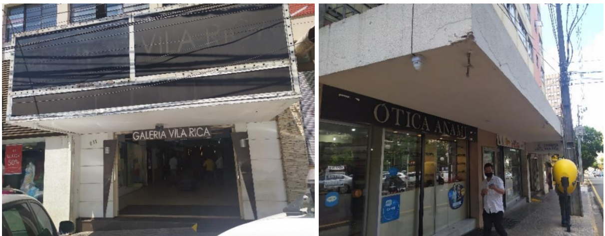
Figura 12 – Fachadas da Galeria Vila Rica.
