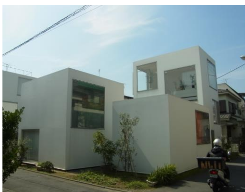
Figura 92 - Moriyama House, 2002-2005. Fonte: do autor (2014)
