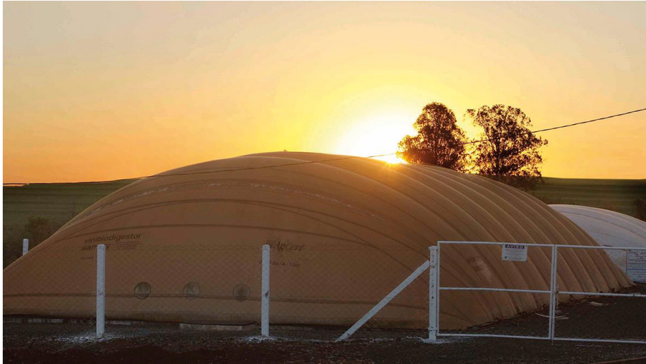
Figura 5 – Biodigestor do Tipo Horizontal
