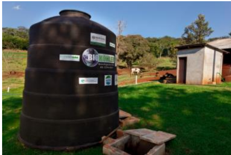
Figura 4 – Biodigestor do tipo vertical
