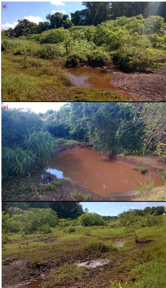
Figura 5 - Foto a) Falta de mata ciliar próximo ao leito do Ribeirão Esperança, demonstrando o processo de assoreamento. Foto b) Processo das margens e assoreamento do leito do Ribeirão Esperança. Foto c) Falta de mata ciliar e erosão ocasionado por passagem de animais.
