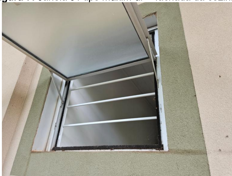
Figura 7: Janela J1 tipo maxim-ar – fachada da cozinha.
