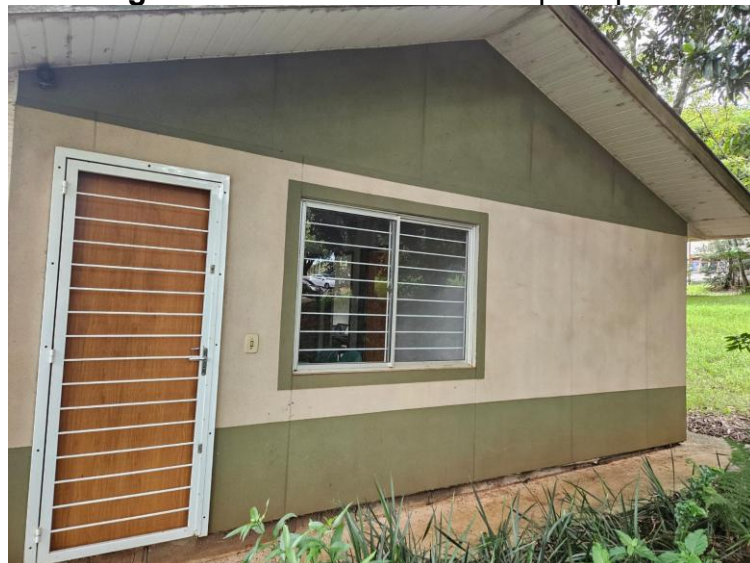
Figura 9: Fachada da entrada principal.
