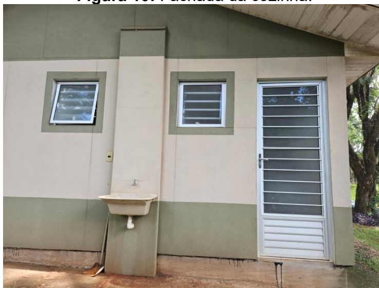
Figura 10: Fachada da cozinha.
