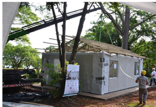
Figura 3: Montagem da habitação de sistema wood-frame.
