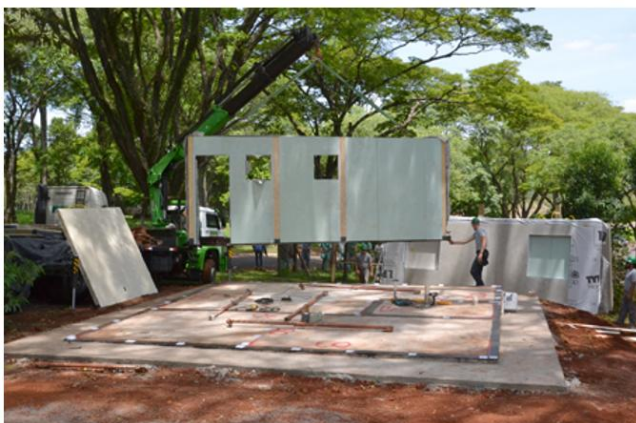
Figura 3: Montagem da habitação de sistema wood-frame.
