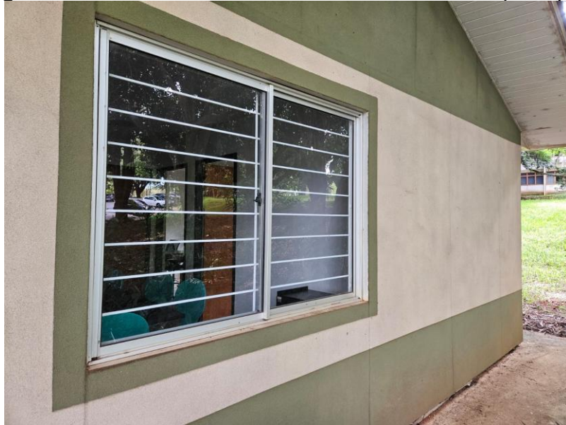
Figura 8: Janela J2 de correr – fachada da entrada principal.
