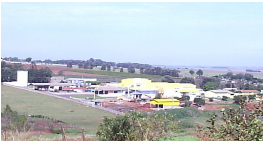
Foto 13: Vista parcial da agroindústria Jaguafrangos, Jaguapitã-PR. Localizada na porção norte da cidade, essa agroindústria fica numa área próxima ao córrego São José, além de ter na circunvizinhança propriedades rurais e dois conjuntos habitacionais. O escoamento de sua produção é viabilizado pela proximidade com a Pr 340 que corta o perímetro urbano norte-sul sentido Rolândia-PR.
