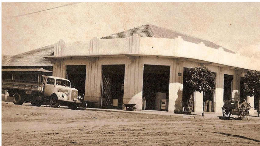
Foto 02: Vista parcial do armazém de secos e molhados “Casa Paratodos” em Jaguapitã-PR, década de 1960.
