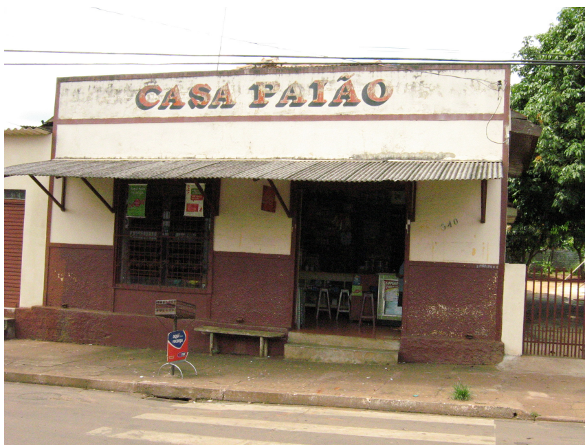
Foto 17: Vista parcial do armazém secos e molhados, Casa Paião em Jaguapitã-PR. Esse estabelecimento situado na Avenida Paraná desde sua instalação em 1976 ainda conserva as mesmas características da referida data.
