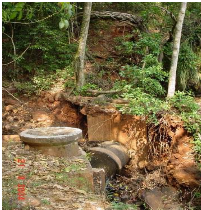
Figura 8 - Emissário da SANEPAR mostrando um processo erosivo no Córrego Monjolo
