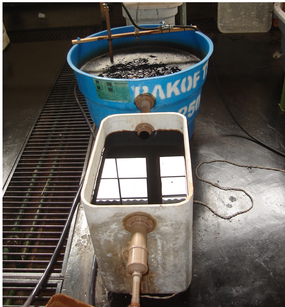
Tanque de aeração e decantador do sistema 2.
