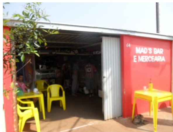
Figura 38 - Bar instalado em unidade habitacional geminada.
