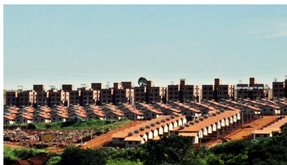
Figura 4 - Vista panorâmica do Vista Bela.
