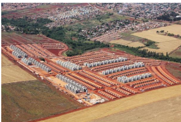
Figura 26 - Vista panorâmica do Vista Bela. Fonte: Retirado do site da construtora Protenge Engenharia, em 29/07/2014.
