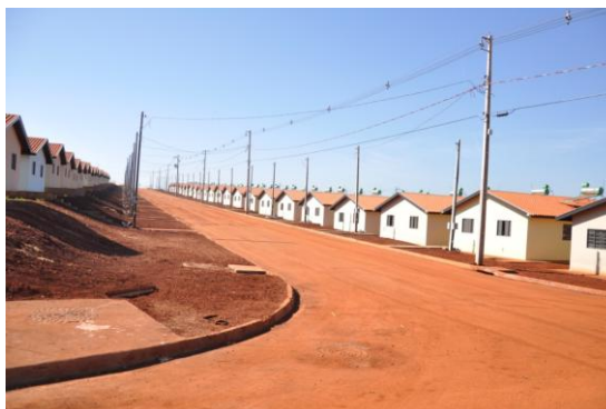
Figura 50 - Início da ocupação do Vista Bela (ausência de muros e acabamentos).
