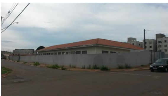
Figura 21 - Praça 1 (desafetada e transformada em creche).
