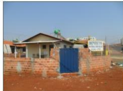
Figura 42 - Dep. mat. de construção.
