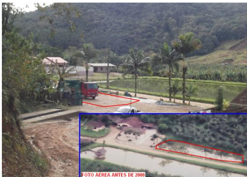
Foto 35 – Alteração do lugar após os deslizamentos de terra (Foto: Autor, 2013)
