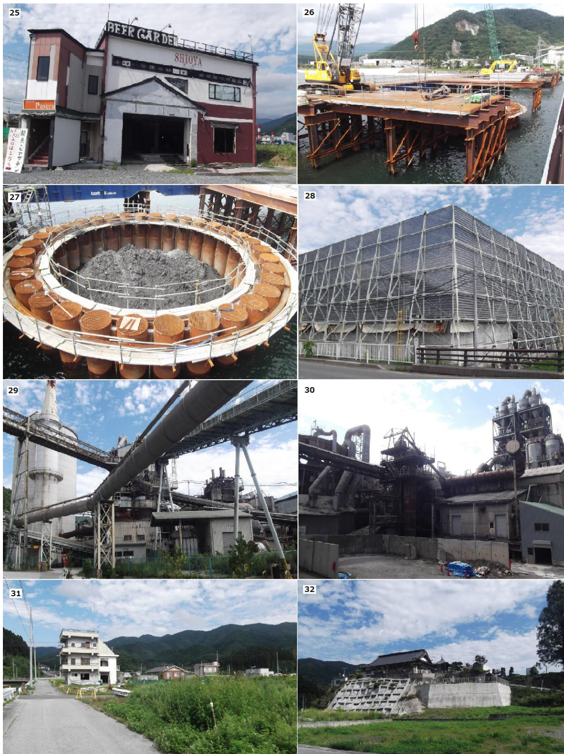
Fotos 37: Fábrica de cimento e habitações abandonadas em Ofunato Fotos: Autor em 2014
