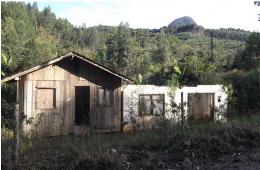
Foto 45 - O abandono após os deslizamentos de terra das residências no Alto Braço do Baú. (Foto: Autor, 2013)
