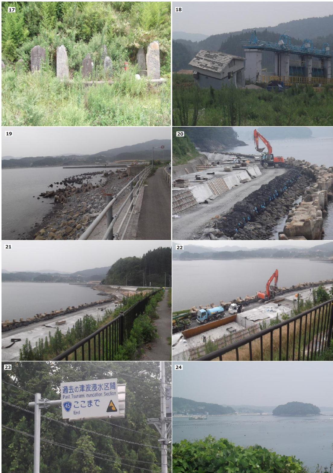
Fotos 16: Reconstrução de orla da baía em Minamisanriku Fotos: Autor em 2014
