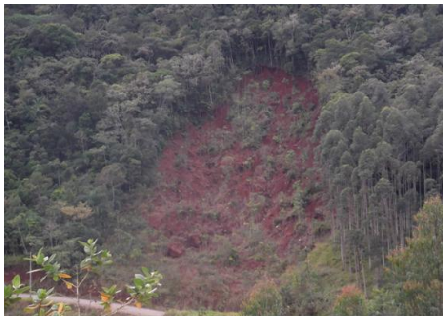
Foto 32 - Na entrada do vilarejo Braço do Baú pode-se notar uma “cicatriz” na montanha onde houve um deslizamento. Um morador que perdeu cinco membros da família e se salvou por ter ido até a casa
