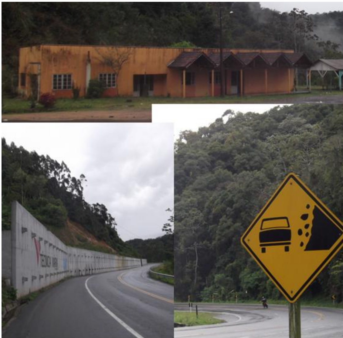
Foto 6 - Na rodovia em sentido Rio Negrinho-PR podem-se perceber novas barreiras de contenção para deslizamentos, que foram instaladas após as enchentes de 2008. Algumas com grande blocos de pedras em telas, e outras em muros de arrime. Placas de sinalização para o perigo de deslizamento são encontradas. Também algumas edificações abandonadas, talvez pelo risco (Foto: Autor, 2013).
