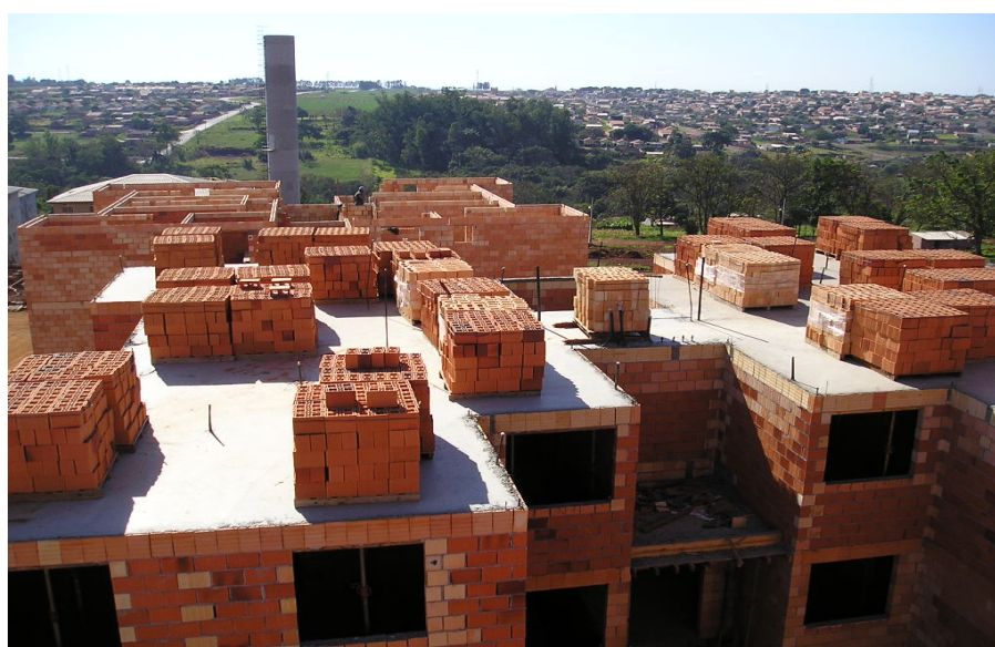
Figura 19 - Armazenagem dos blocos na laje.
