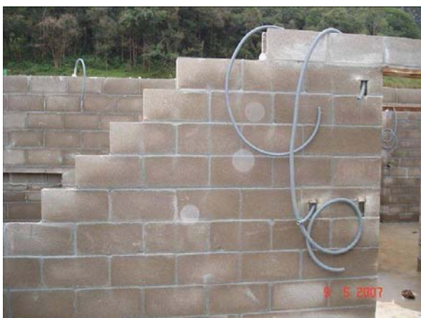
Figura 22 - Elevação em “escada”
