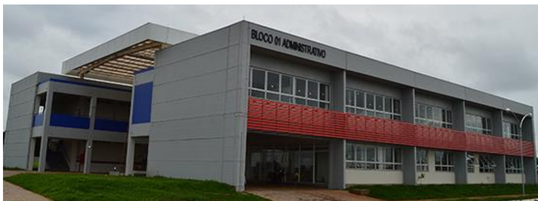
Figura 2 – Prédio Padrão Bloco 01 Administrativo
