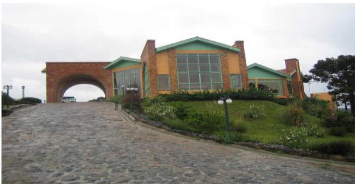
Fotografia 2 – Acesso interno à cantina.
