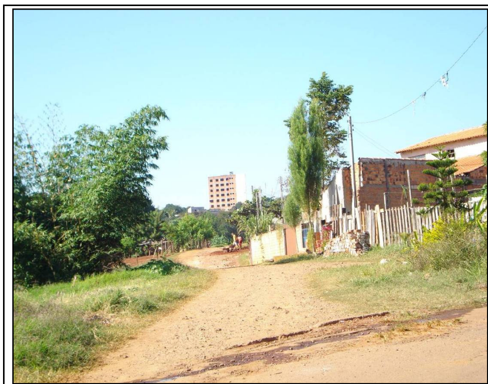
Foto 04: Entrada principal do Jardim San Rafael: na foto é possível visualizar a ausência de asfaltamento no local
