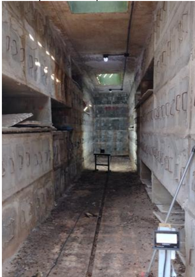
Foto 20: Vista da estrutura de lóculos do chamado “Conjugado Allamandas”, observar, no alto, as aberturas por onde os sepultamentos são feitos.
