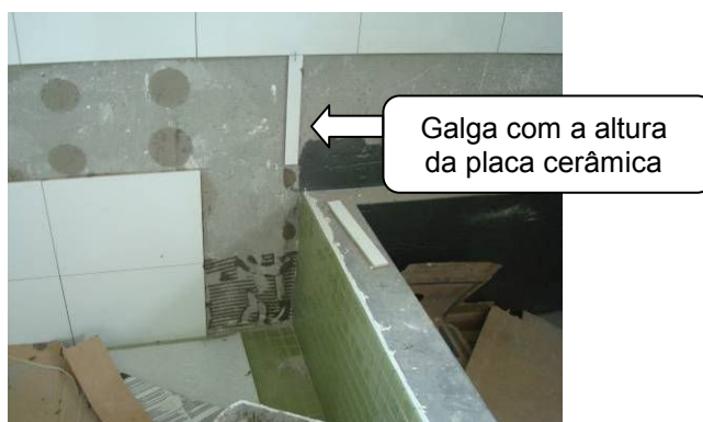
Figura 21 - Utilização de galga na vertical para a altura da placa cerâmica
