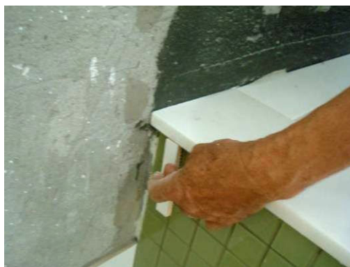
Figura 22 - Galga utilizada para a medida da pingadeira de granito
