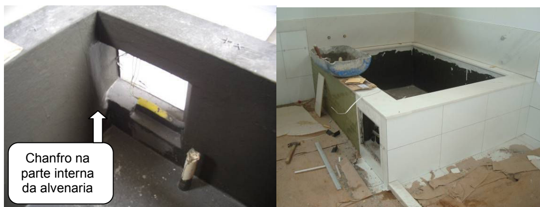
Figura 23 - Chanfro interno e configuração final dos revestimentos da banheira
