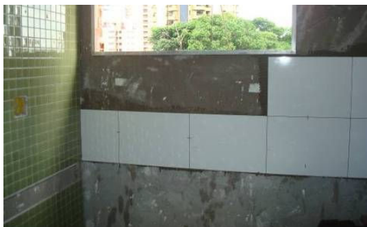
Figura 19 - Início do assentamento das placas cerâmicas
