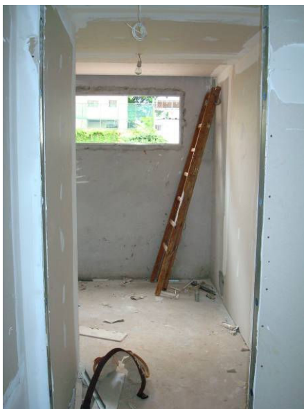
Figura 38 - Paredes do Protótipo Físico executadas sem a parede de apoio da banheira
