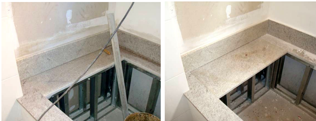
Figura 45 - Substituição da peça de granito da banheira
