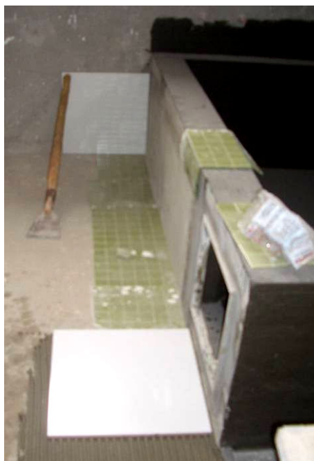
Figura 17 - Galga para início do assentamento do piso cerâmico
