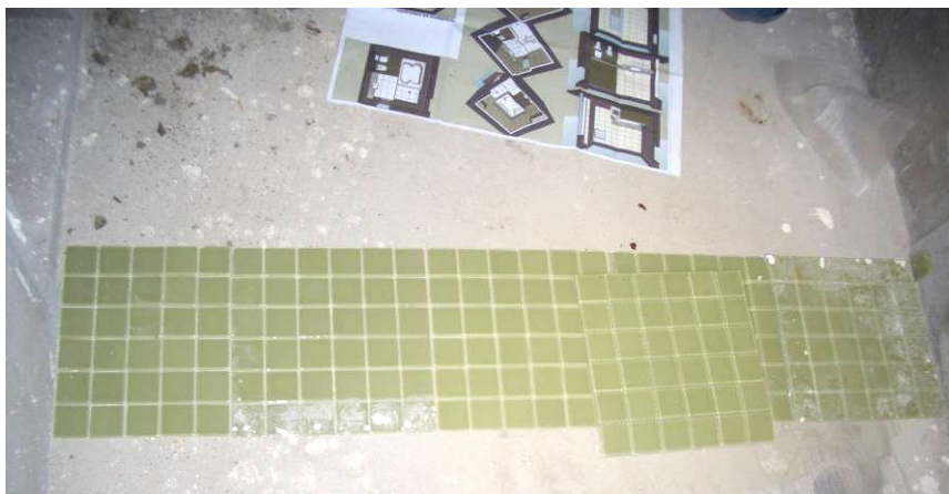
Figura 16 - Galga de pastilhas elaborada para o posicionamento da parede da banheira
