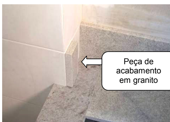
Figura 46 - Teste para verificar o acabamento da peça de granito.
