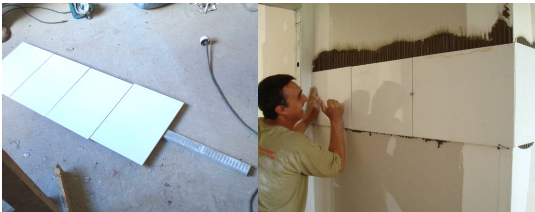
Figura 40 - Galga elaborada e assentamento das placas cerâmicas a partir da altura
