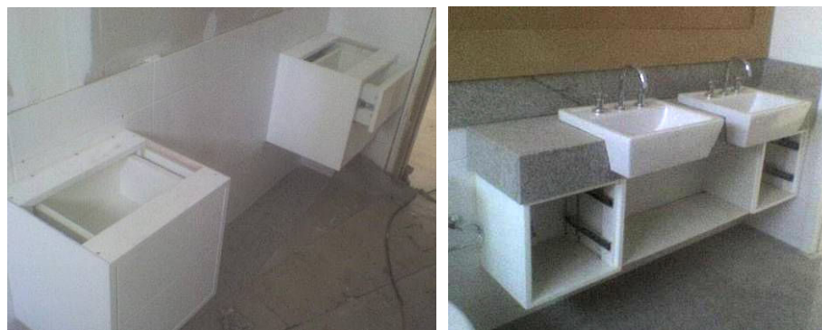
Figura 47 - Mobiliário executado para sustentação da bancada de granito e execução final da bancada com as cubas.
