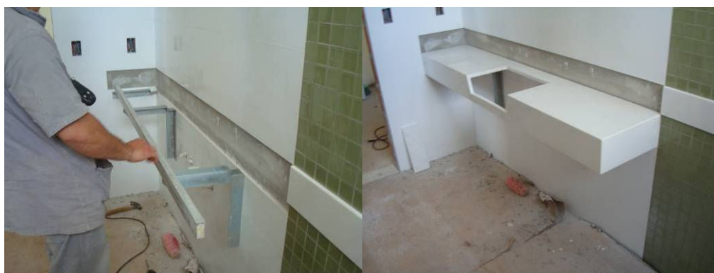
Figura 24 - Fixação dos montantes e cantoneiras e colocação da bancada
