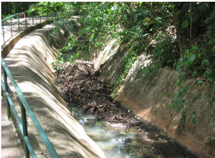
Imagem 15 – Situação do canal de escoamento
