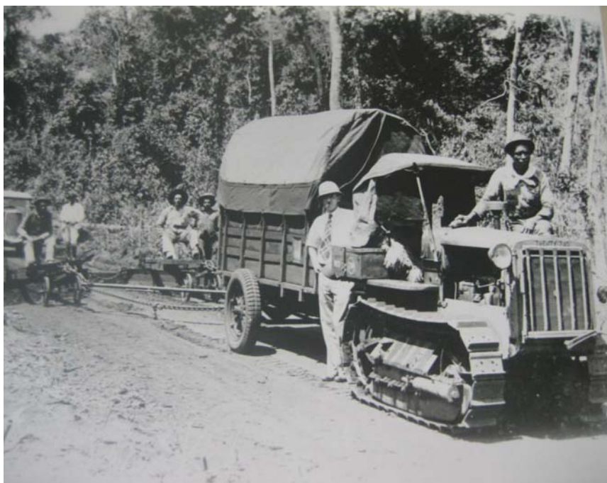
Imagem 22 – Construção de estrada no Norte do Paraná na década de 30.
