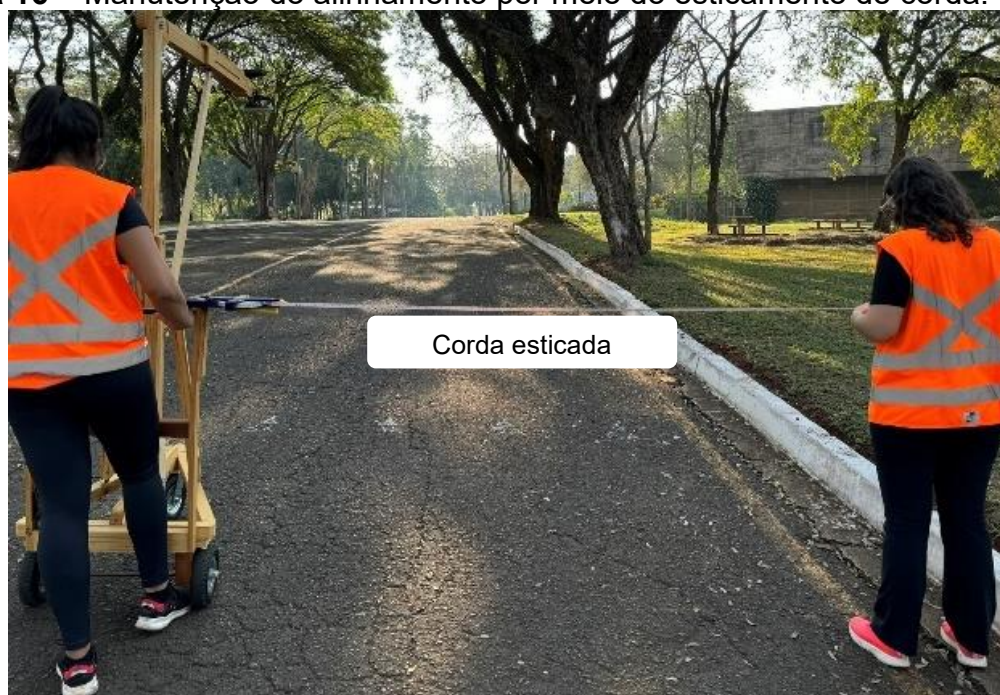
Figura 16 – Manutenção do alinhamento por meio do esticamento de corda.
