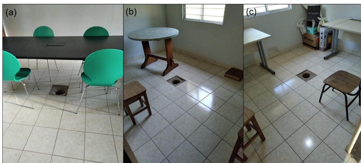
Figura 7 - Pisos perfurados nos ambientes: (a) Sala; (b) Dormitório 1; (c) Dormitório 2
