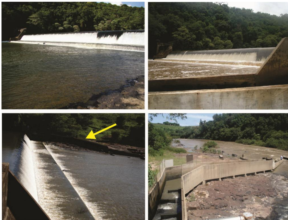
Figura 2 – Usina da Corredeira no rio Laranjinha ( 23^{\circ}24'53.06''S / 50^{\circ}27'8.60''O ), a barragem possui aproximadamente 5m de altura. A seta amarela indica a escada de transposição inaugurada em 2006. (FOTOS: do autor).
