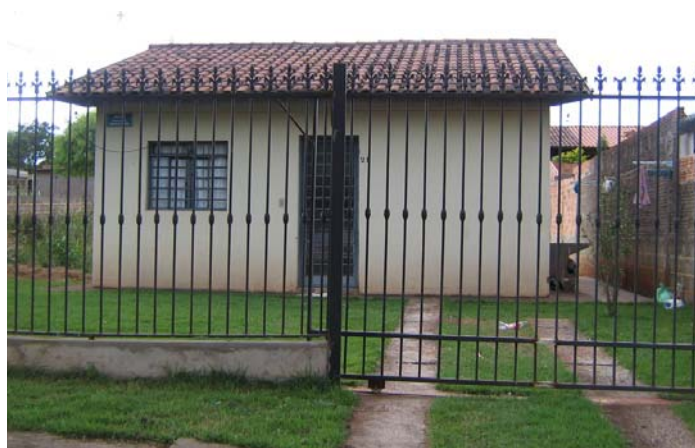
Figura 16 - Fachada da edificação de tipologia 1.
