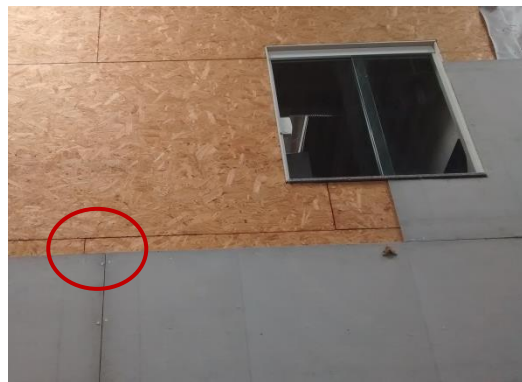
FIGURA 67: Exemplo do transpasse mínimo (15cm) entre as juntas das placas OSB e cimentícias
