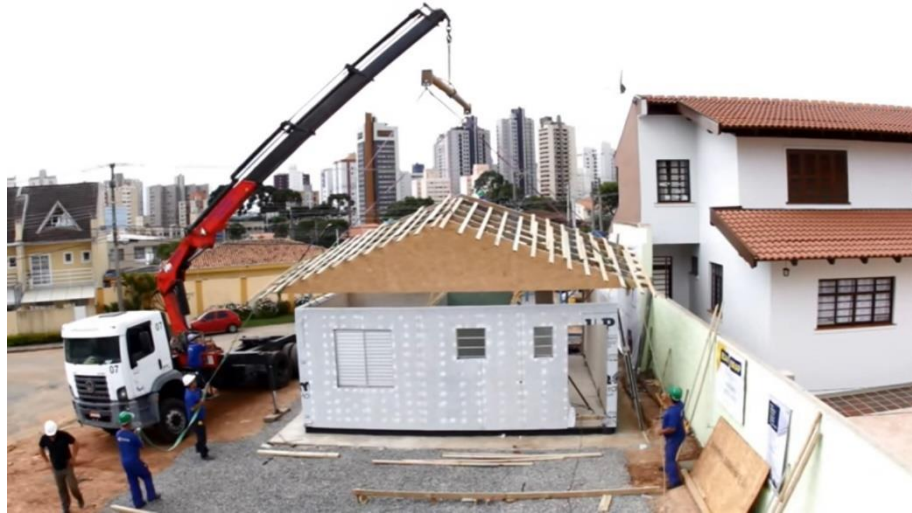
FIGURA 20: Instalação do subsistema de cobertura quando é viável a montagem da estrutura em solo
