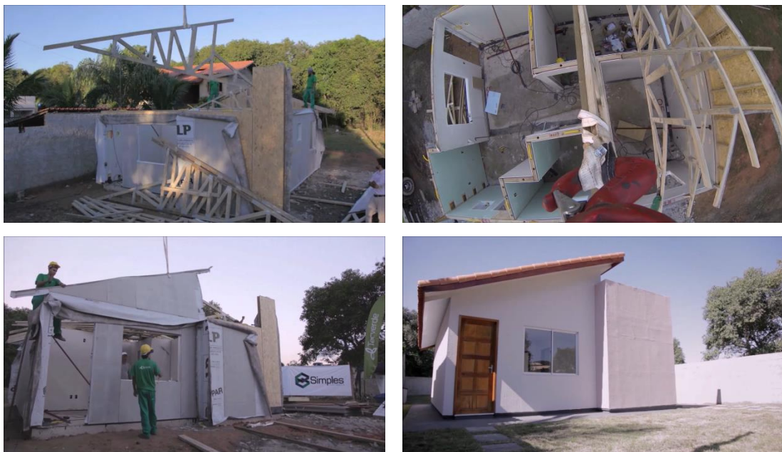
FIGURA 21: Etapas de instalação do subsistema de cobertura quando não é viável a montagem da estrutura em solo
