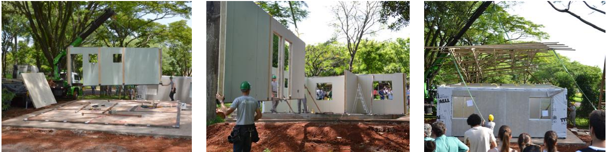
FIGURA 19: Etapas de montagem do protótipo
