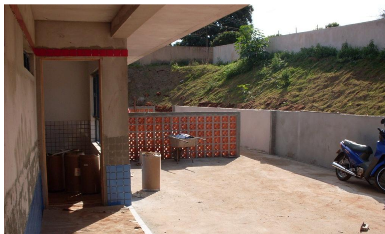
Figura 40 – Foto do CMEI Marisa Arruda com vista da área de terreno cortada, em nível abaixo do nível da rua.
