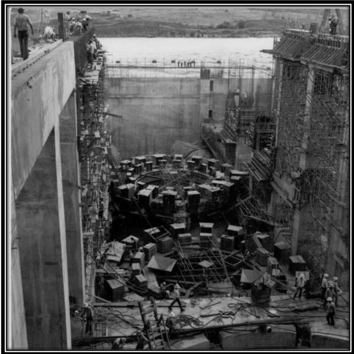
Figura 5 – Montagem dos grupos geradores da usina Capivara, 1975
