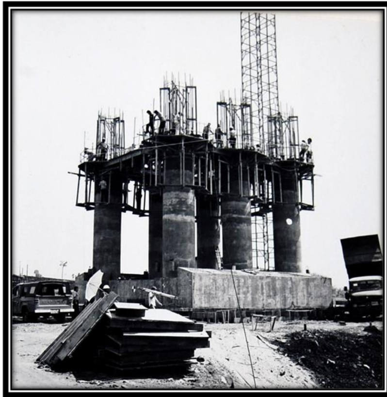
Figura 3 – Construção de obra de concreto na barragem de Capivara
