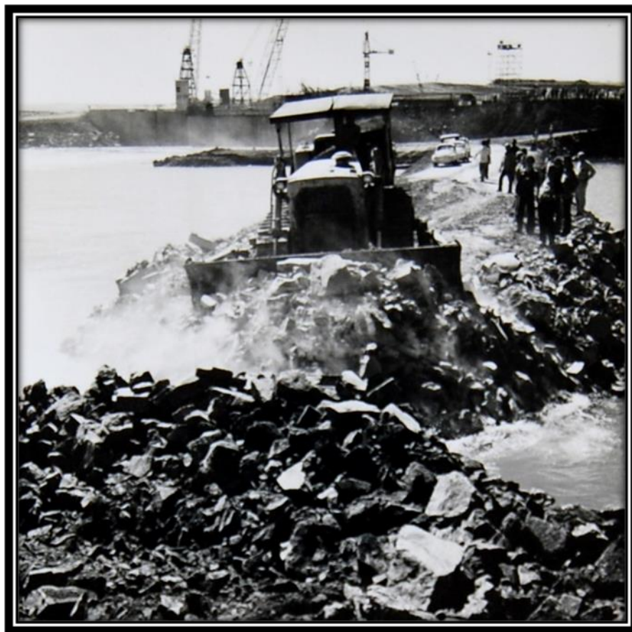
Figura 2 – Trator realiza obras do desvio de segunda fase do rio Paranapanema
