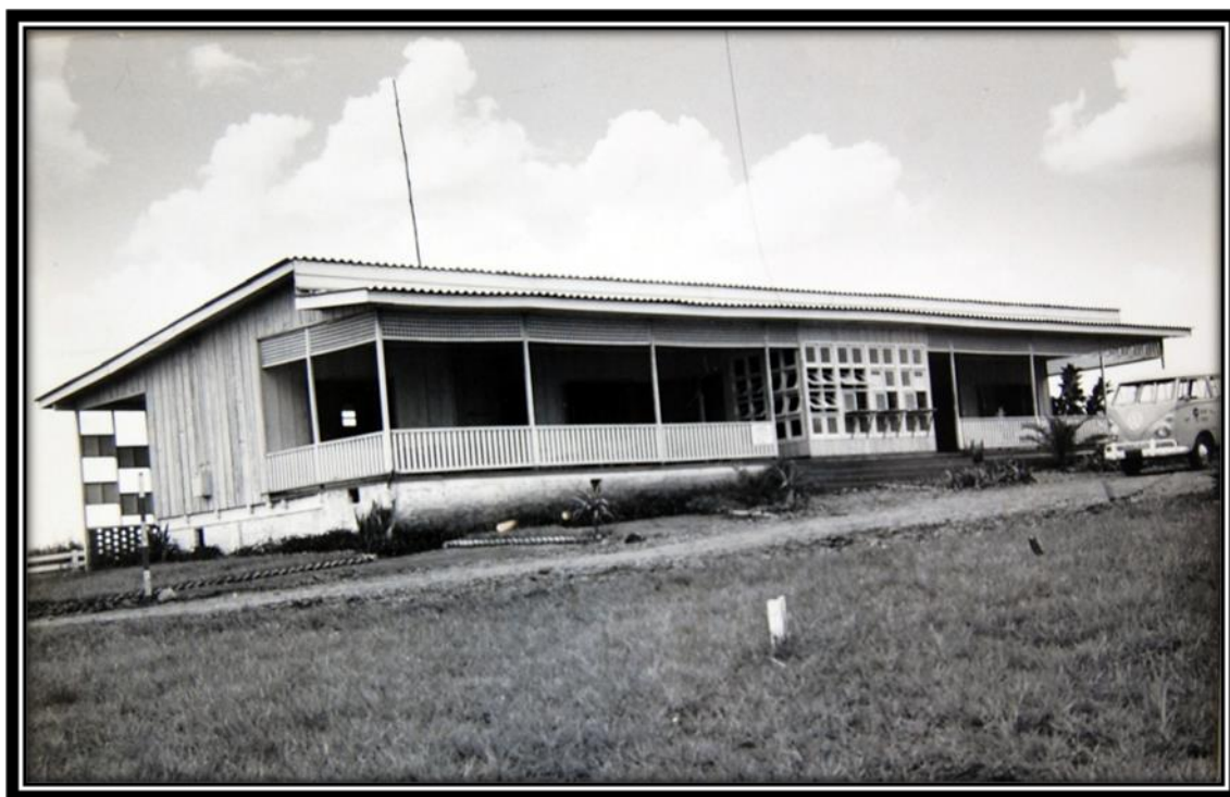
Fotografia: Autor desconhecido Fonte: Relatório de construção elaborado pela CESP em 1974
