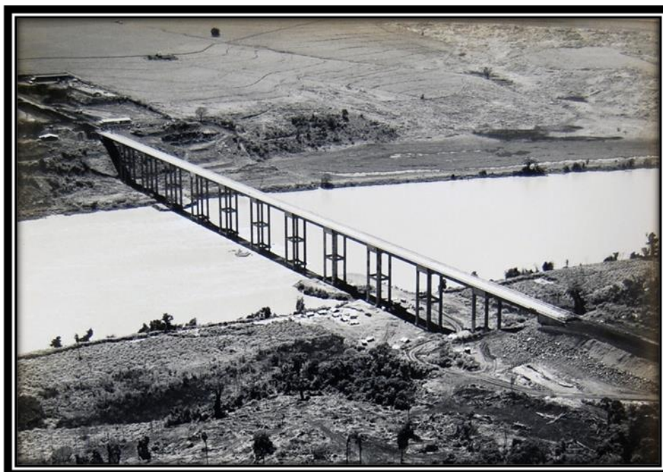
Figura 9 – Ponte sobre o rio Paranapanema
