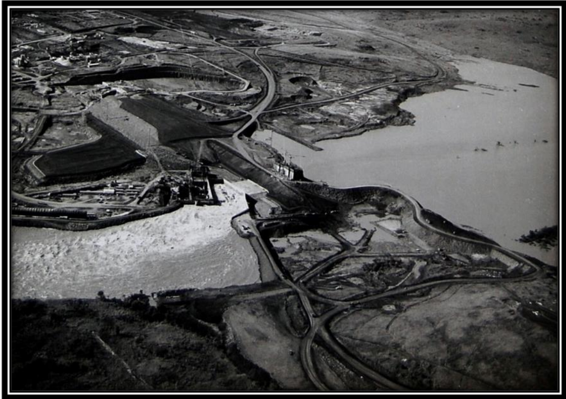
Figura 1 – Imagem aérea do canteiro de obras da usina de Capivara
