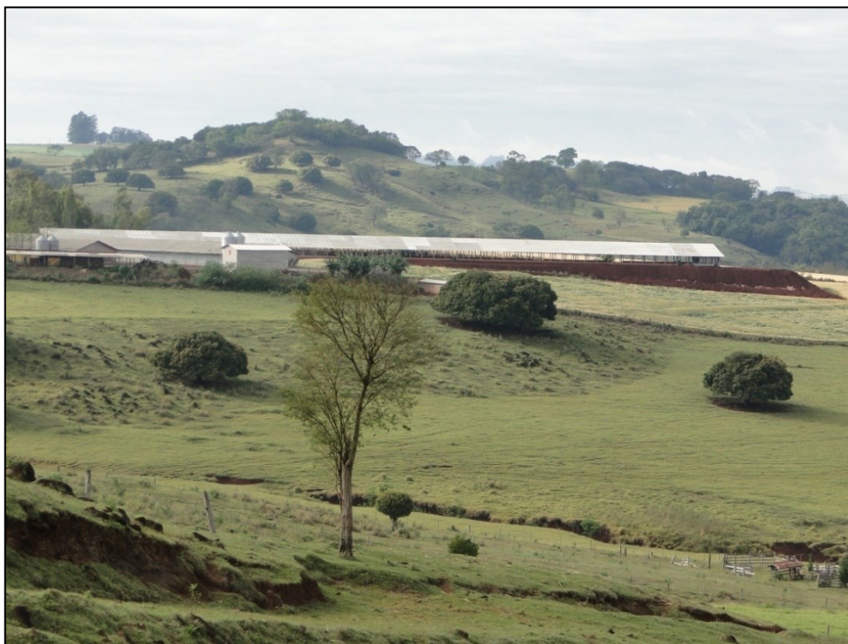
Foto 15: Construção de granja de frangos em uma propriedade camponesa na comunidade rural Molina em Rio Bom/PR.
