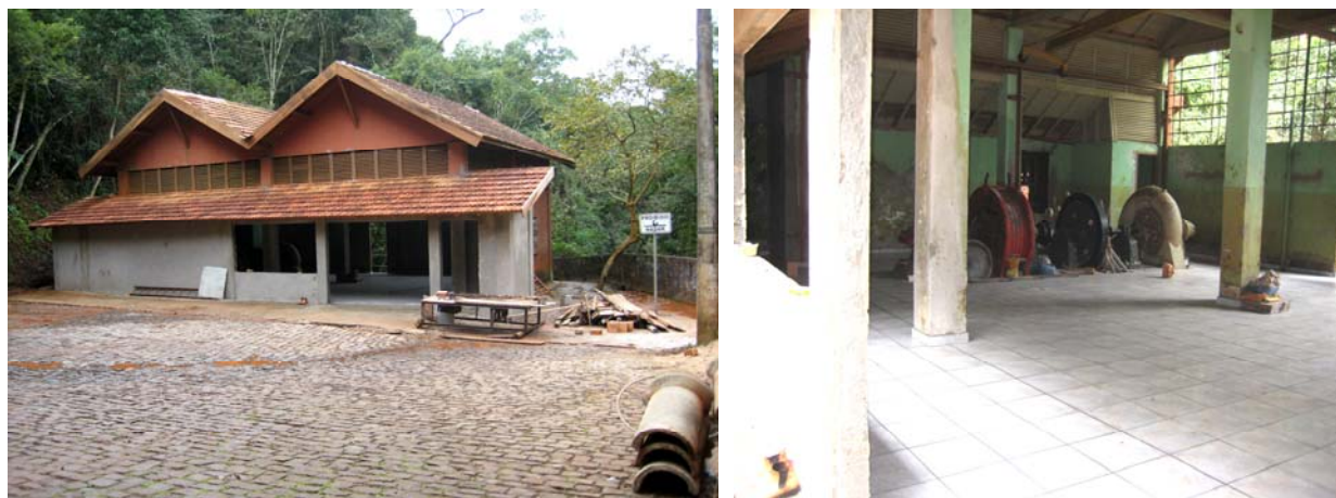
Figura 29 – Usina Cambé em obras – exterior e interior. Autoria: Míriam P. Coradini, 2008.
