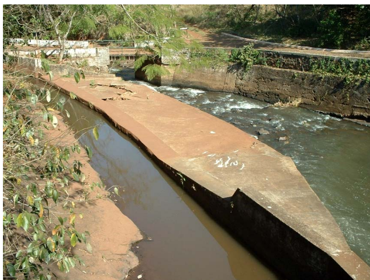
Figura 24 – Canal lateral, antiga fonte de abastecimento da usina hidrelétrica.
