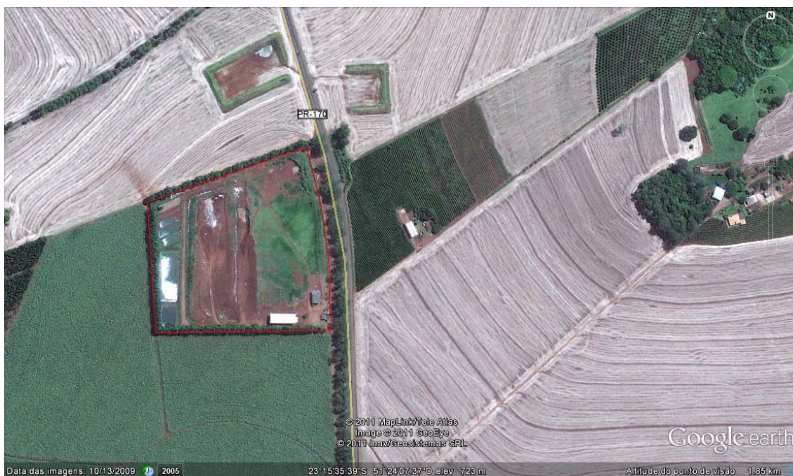
Figura 4.1 - Vista aérea do Aterro de Resíduos Sólidos Urbanos de Rolândia (PR).
