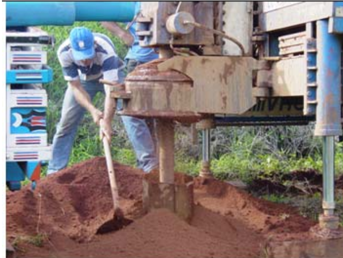
Figura 22 – Detalhe da perfuração do PM 06
