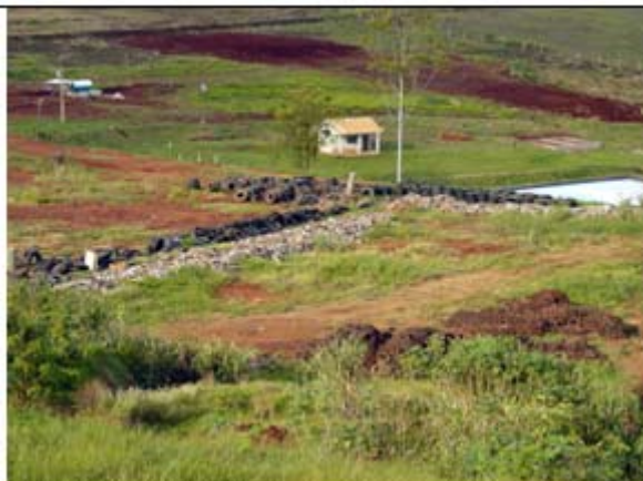
Figura 16 – Detalhe dos drenos horizontais feitos de pneus
