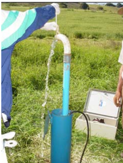
Figura 32 – Desenvolvimento do poço de monitoramento
