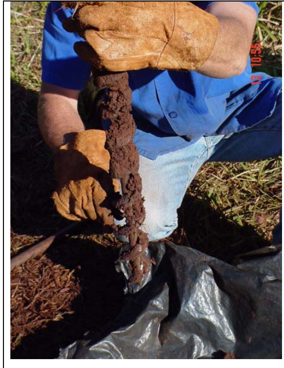
Figura 34 – Coleta de amostra com o trado de avanço da sondagem
