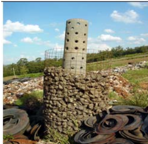
Figura 17 – Detalhe dos drenos verticais de gás
