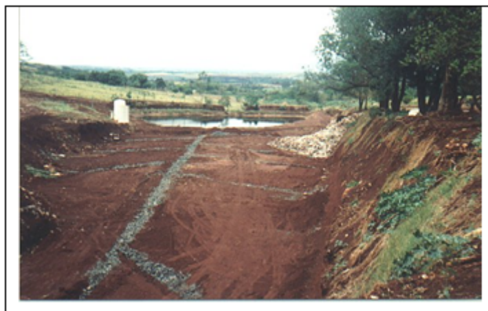
Figura 15 – Detalhe dos drenos horizontais implantados na área antiga do aterro
