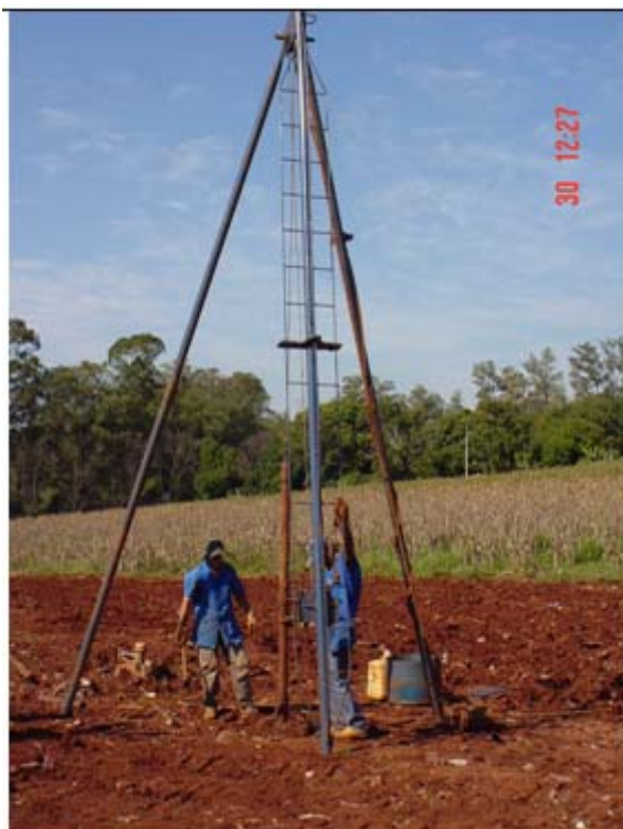
Figura 28 – Detalhe do ensaio de SPT in situ
