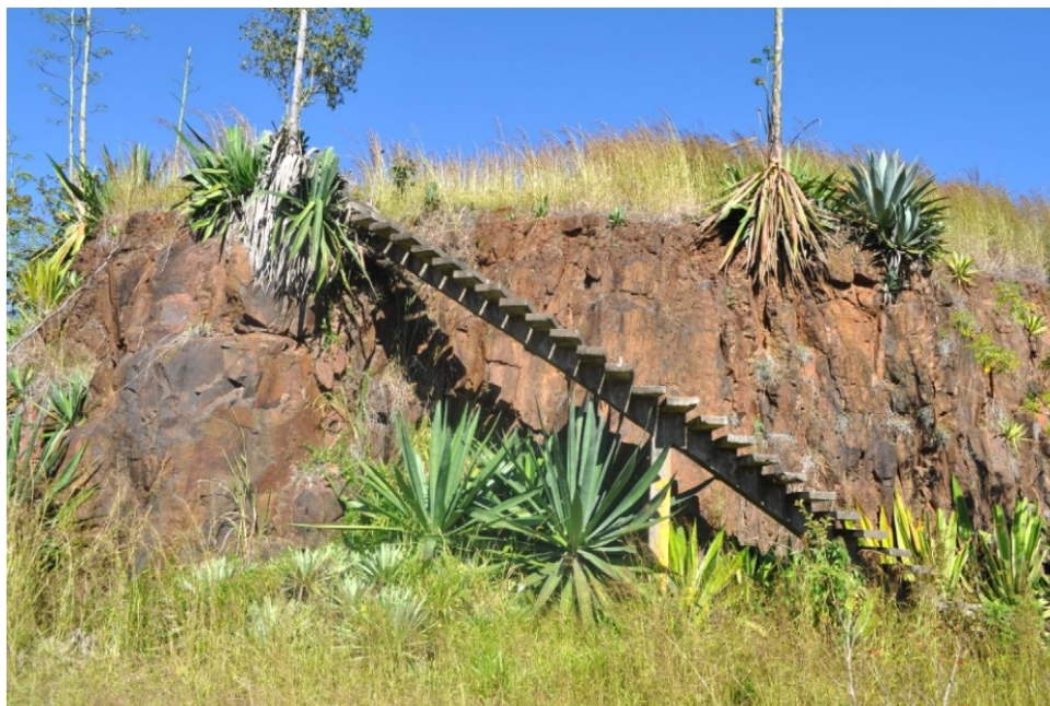
Figura 6 – Afloramento de basalto com alto teor de ferro na margem esquerda da rodovia PR-439
