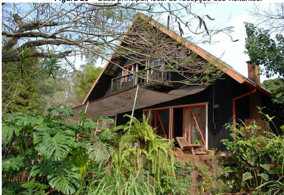
Figura 23 – Casa principal, local de recepção dos visitantes.
