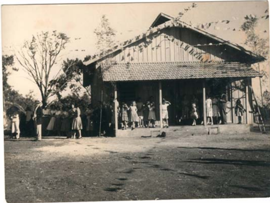
Figura 5 – Edificação em madeira - Primeira instalação da Paróquia Nossa Senhora de Lourdes – Londrina/PR Fonte: Arquivo da Paróquia Nossa Senhora de Lourdes – Londrina/PR Obs. Estima-se que o registro foi feito entre os anos de 1957 e 1958
