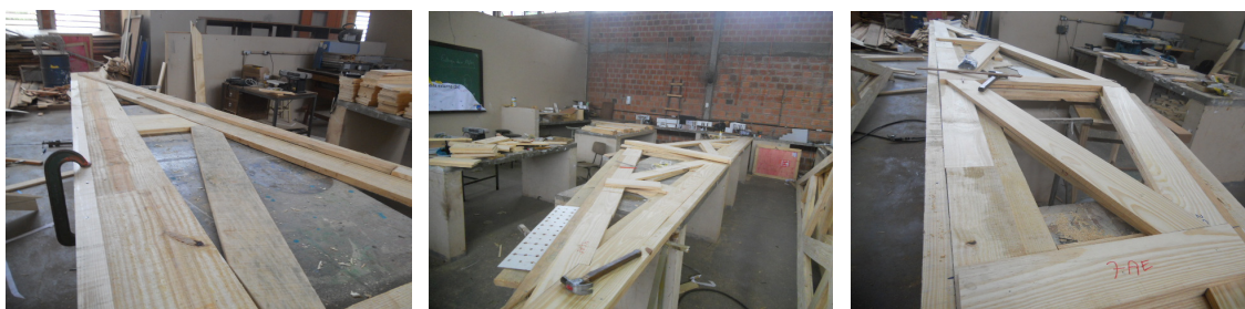
Figura 62 Fotos do gabarito executado para a execução das 6 amostras. Fonte: Autora.
