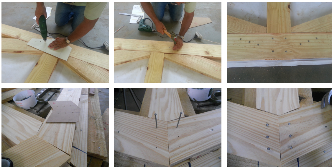
Figura 61 Fotos da utilização do gabarito, montagem/pré-furação das peças e MLP após pregação. Fonte: Autora.
