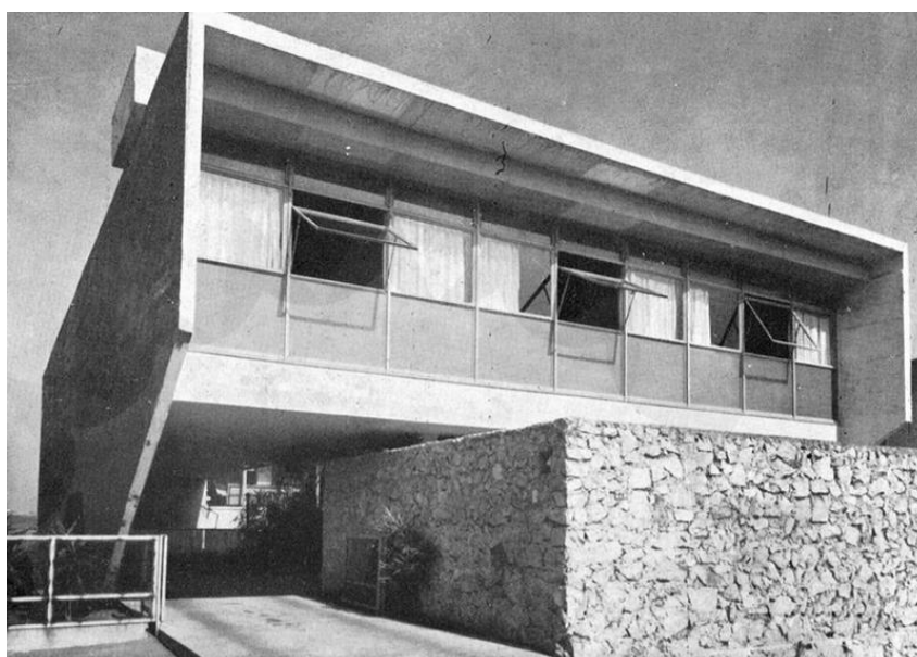
Figura 160: Residência Mario Taques Bittencourt, São Paulo, Brasil 1962.
