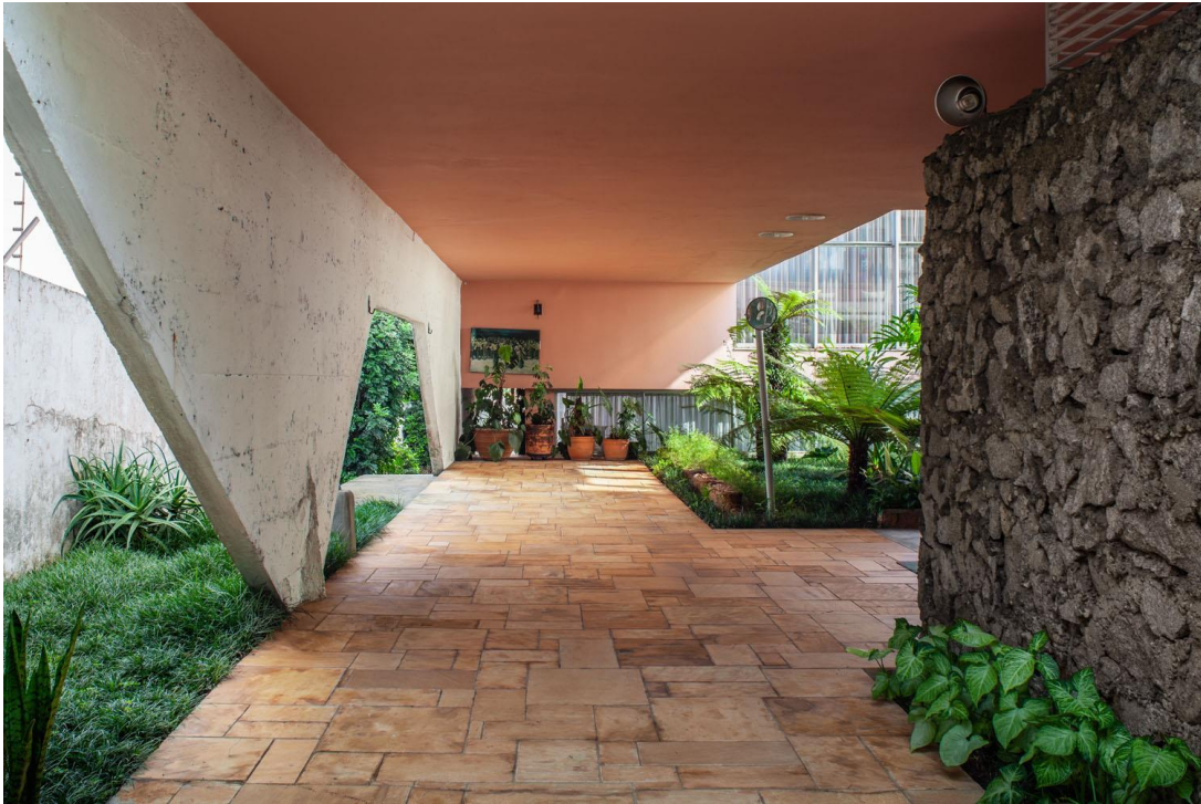
Figura 161: Residência Mario Taques Bittencourt, São Paulo, Brasil 1962.
