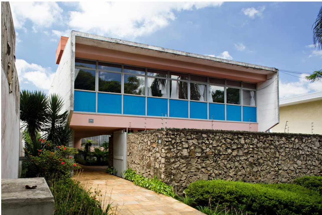
Figura 162: Residência Mario Taques Bittencourt, São Paulo, Brasil 1962.
