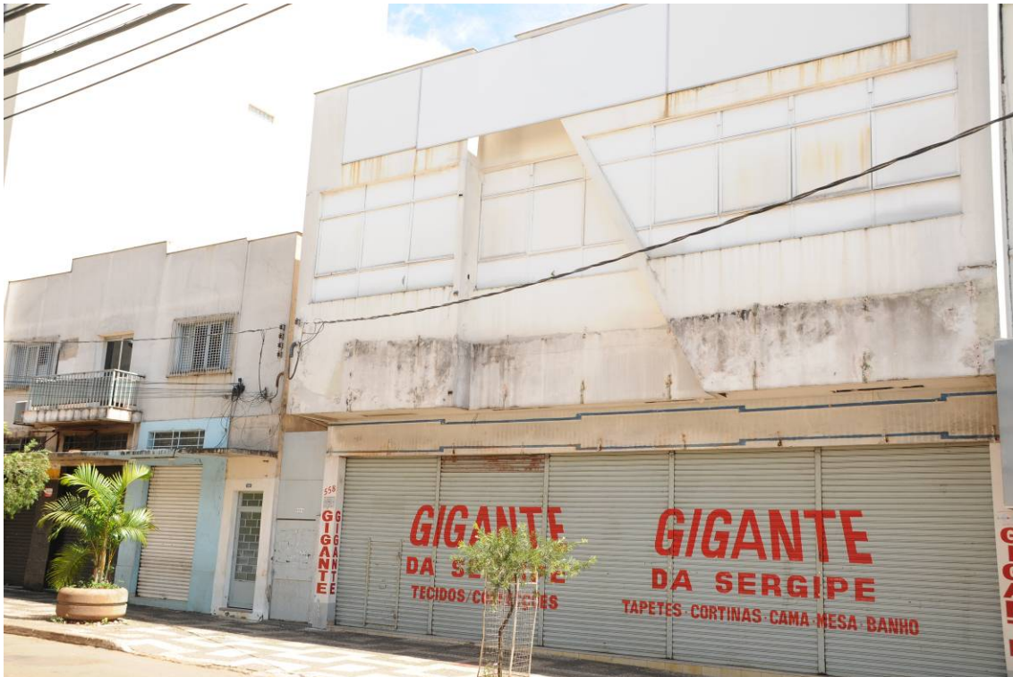
Figura 22 - Fachada Gigante da Sergipe.
