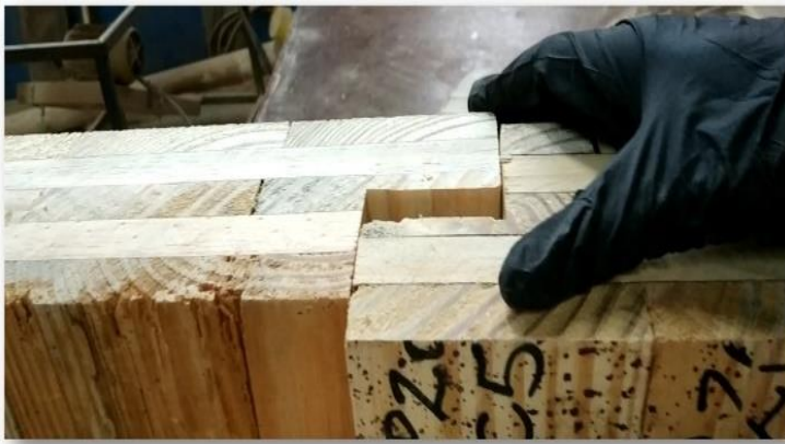
Figura 47: Painéis com junta half-lap .
