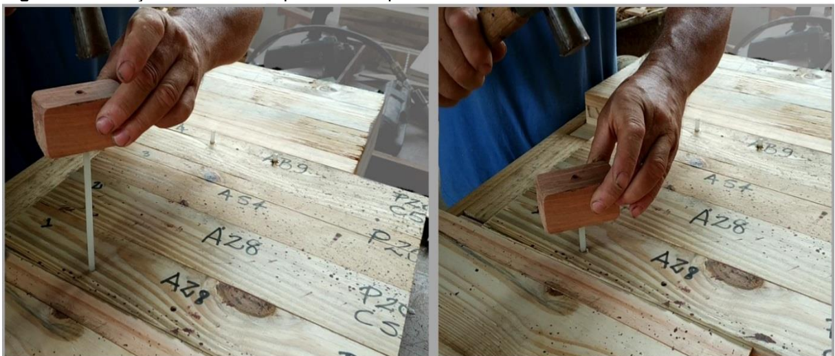
Figura 54: Inserção da cavilha no pré-furo dos painéis.
