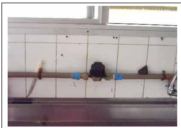
Figura 17 – Empresa “A” - Hidrômetros do setor de hortifruti
