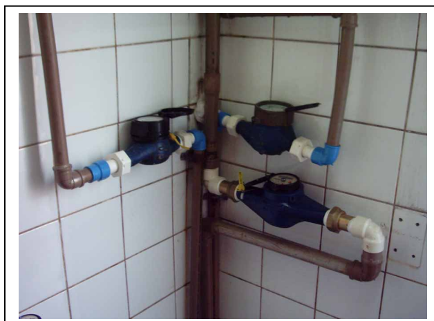
Figura 16 – Empresa “A”- Hidrômetros do consumo geral da UAN
