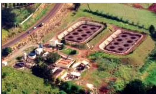
Figura 2 – Foto aérea de uma estação de tratamento de efluentes de indústria de café solúvel pelo processo de aeração prolongada
