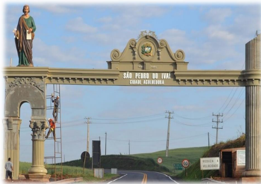
Figura 30 – Pórtico em São Pedro do Ivaí
