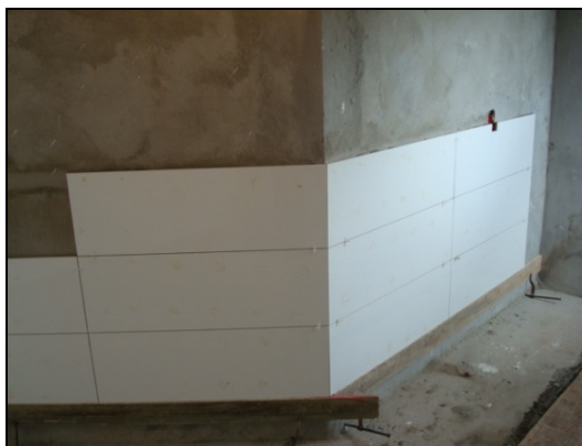
Figura 2 - Encontro das placas nas quinas
