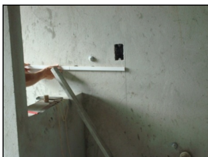
Figura 43 - Definição dos cortes
