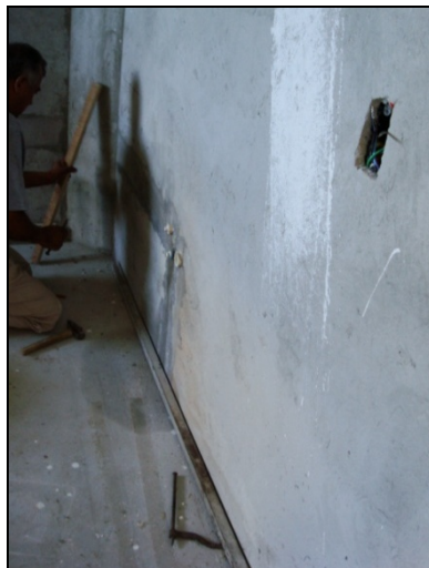
Figura 4 - Marcação dos pontos de partida e chegada do assentamento
