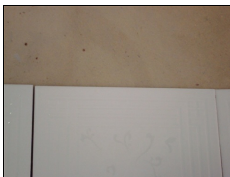
Figura 10 - Variação na largura da placa
