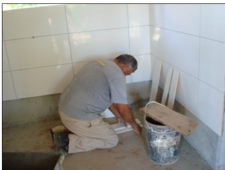
Figura 6 - Marcação dos cortes nas placas
