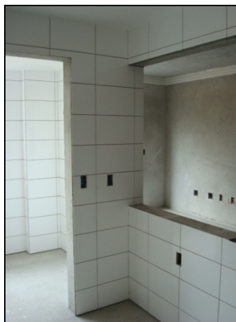
Figura 46 - Presença de muretas e aberturas
