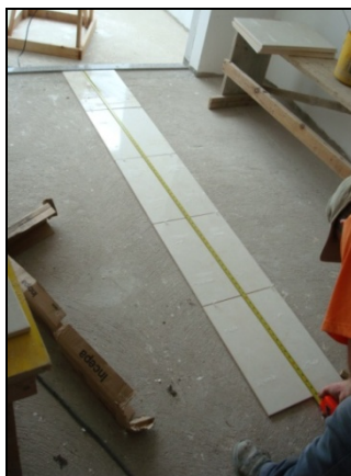
Figura 36 - Definição das fiadas de placas
