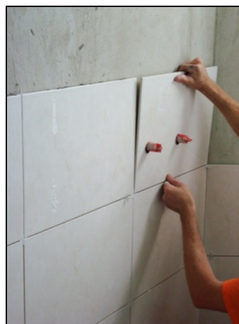
Figura 11 - Adequação aos elementos hidráulicos
