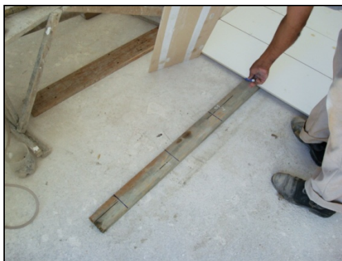
Figura 7 - Marcação das alturas das placas na régua
