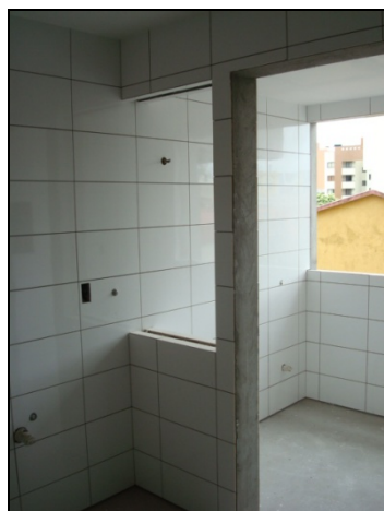
Figura 12 - Presença de muretas e aberturas
