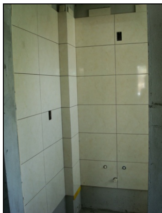
Figura 34 - Ressaltos na parede
