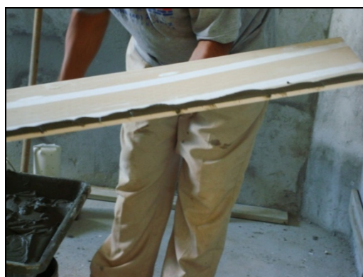
Figura 3 - Manuseio de placas de grandes dimensões
