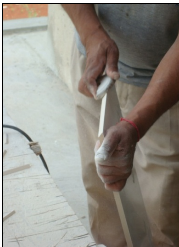
Figura 10 - Acabamento na aresta da placa
