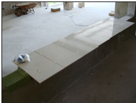
Figura 8 - Placas assentes sobre a régua
