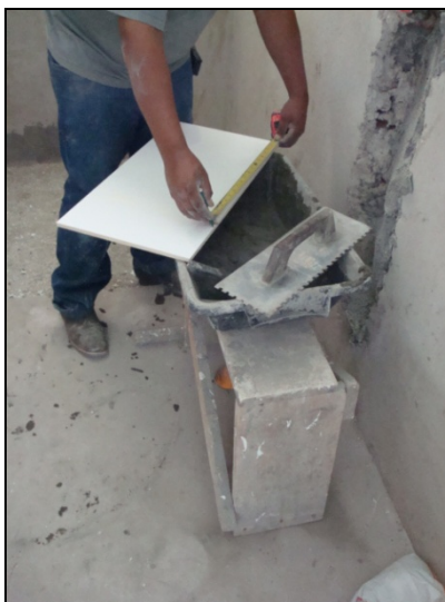
Figura 21 - Medição e marcação do corte
