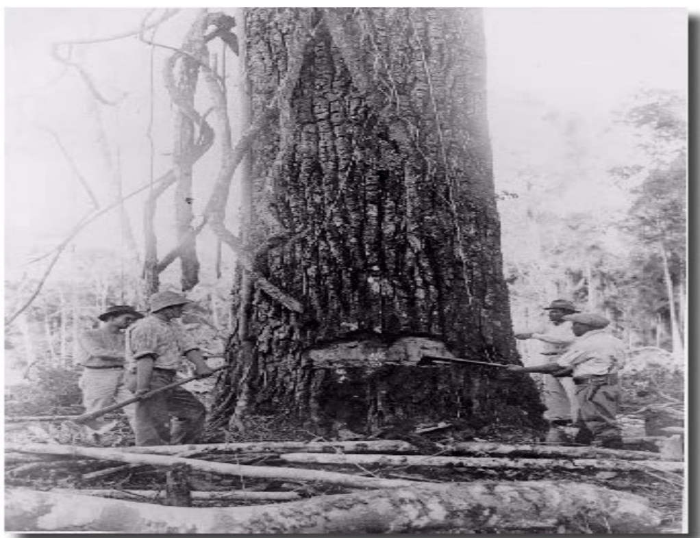
Figura 4 – Foto de trabalhadores abrindo a região.
