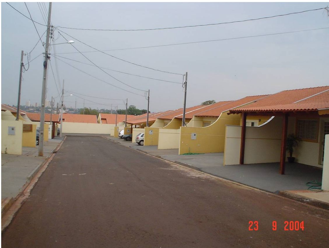
Figura 27 – Foto do Condomínio Osamo Takeda, de pequeno porte, já habitado, em 2004. (Foto de 23/09/2004)
