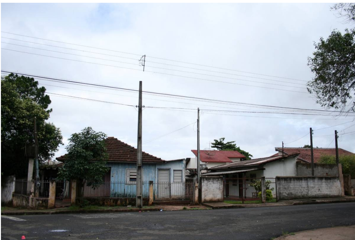
Foto 12 – Área de assentamento apto a regularização. (Foto de 18/10/2009)
