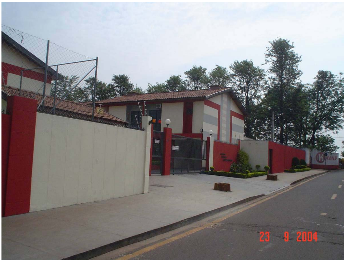
Figura 20 – Entrada de condomínio de pequeno porte Alto Pinheiros. (Foto de 23/09/2004)
