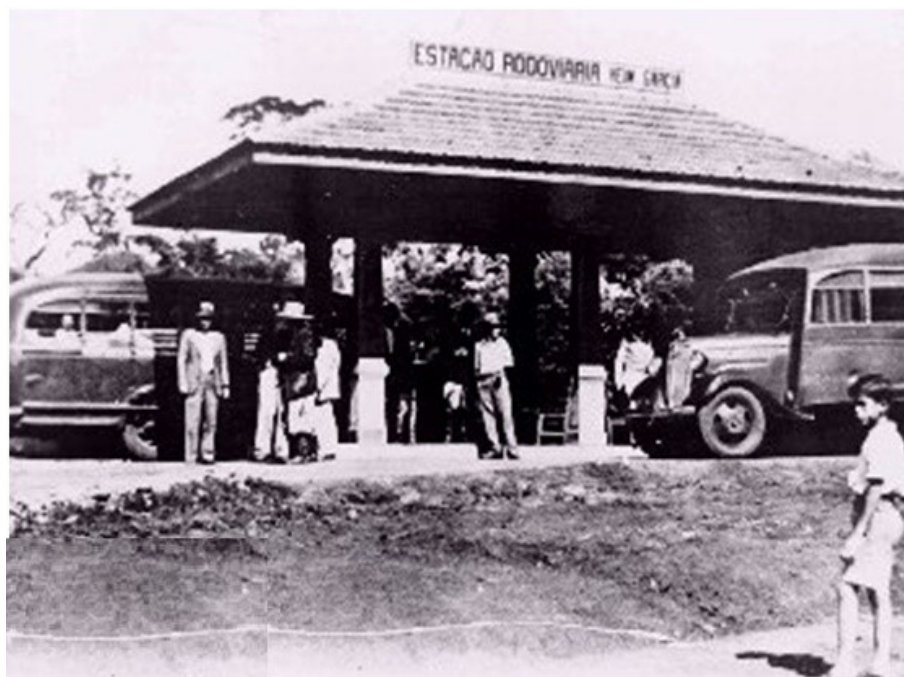
Figura 13 – Primeira Estação Rodoviária de Londrina, na atual Praça Willie Davids; Celso Garcia Cid é o primeiro à esquerda
