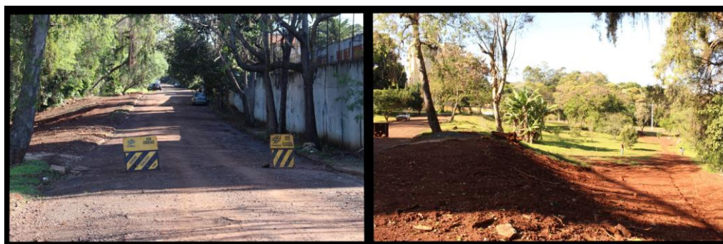
Figura 18: Obra de infraestrutura sendo realizada no Jardim Cláudia.
