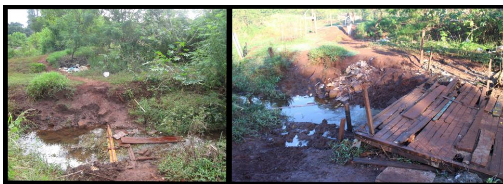
Figura 29: Estrutura para a travessia do Córrego dos Crentes.
