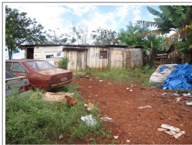
Figura 25: Casas irregulares construídas no fundo de vale no Jardim Cristo Rei.
