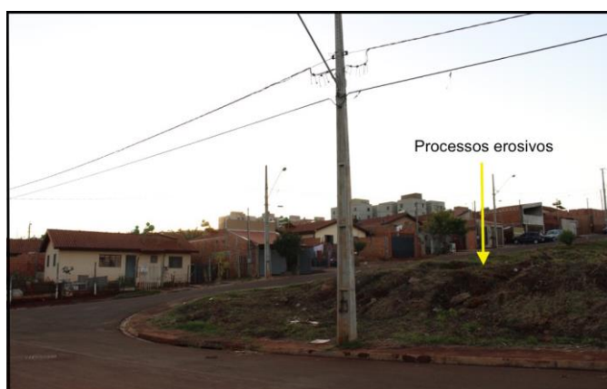
Figura 51: Feições erosivas na área residencial do Residencial Vista Bela.
