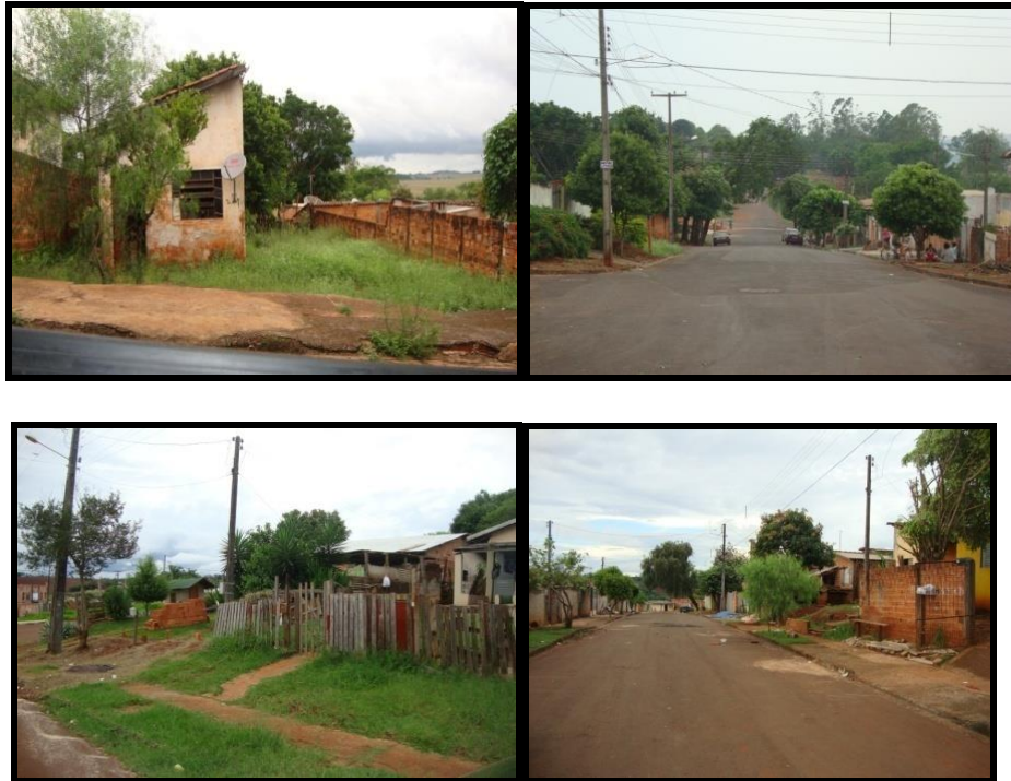
Figura 12: Casas construídas pelo programa Habitar Brasil no João Turquino Mônica Dias Ribeiro - Nov.2015.
