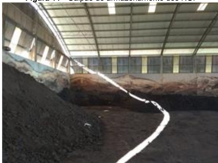
Figura 11 - Galpão de armazenamento dos RGP
