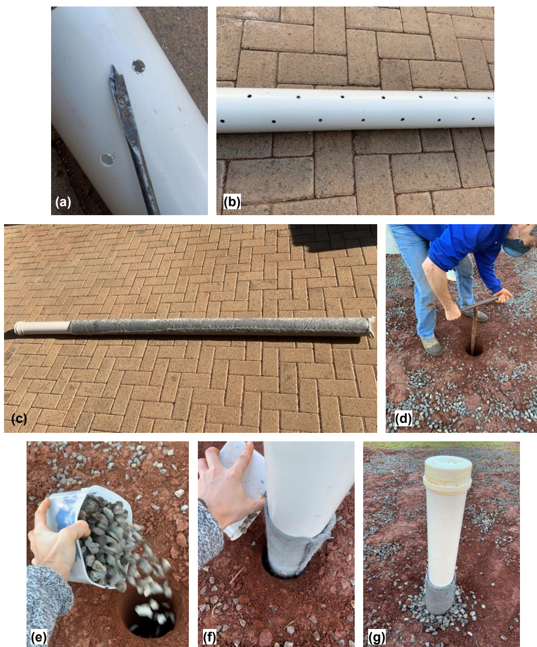
Figura 5.30 – Sequência construtiva do furo de sondagem
