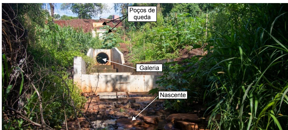
Figura 5.21 – Galeria e poços de queda pluvial construídos
