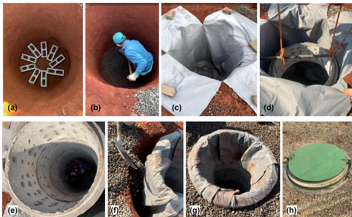
Figura 5.28 – Sequência construtiva do poço de infiltração
