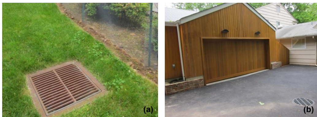
Figura 3.4 – Grade de poços secos em (a) um gramado e em (b) um pátio
