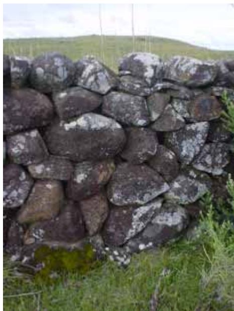
Figura 30. Sistema construtivo de juntas s ecas, denominados “taipas” na região. Foto: Rodrigo Meira Martoni.
