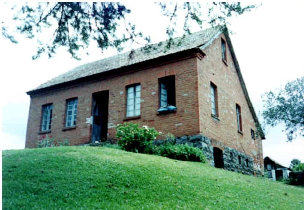
Figura 48. Fazenda Tijolinho. Edificação em tijolos aparentes. Foto: Rodrigo Meira Martoni.
